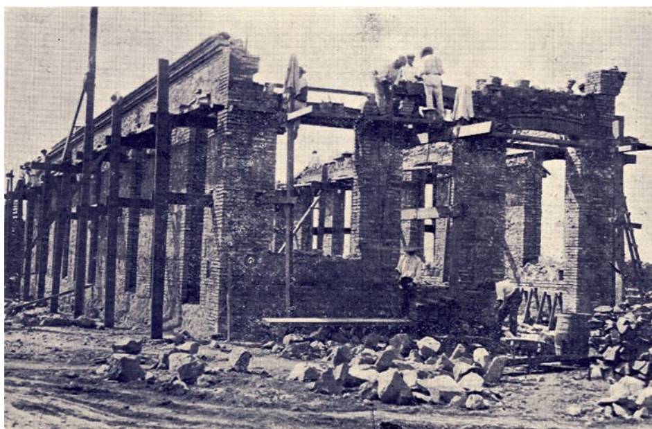
Aspectos del Matadero municipal en construcción, 1928
